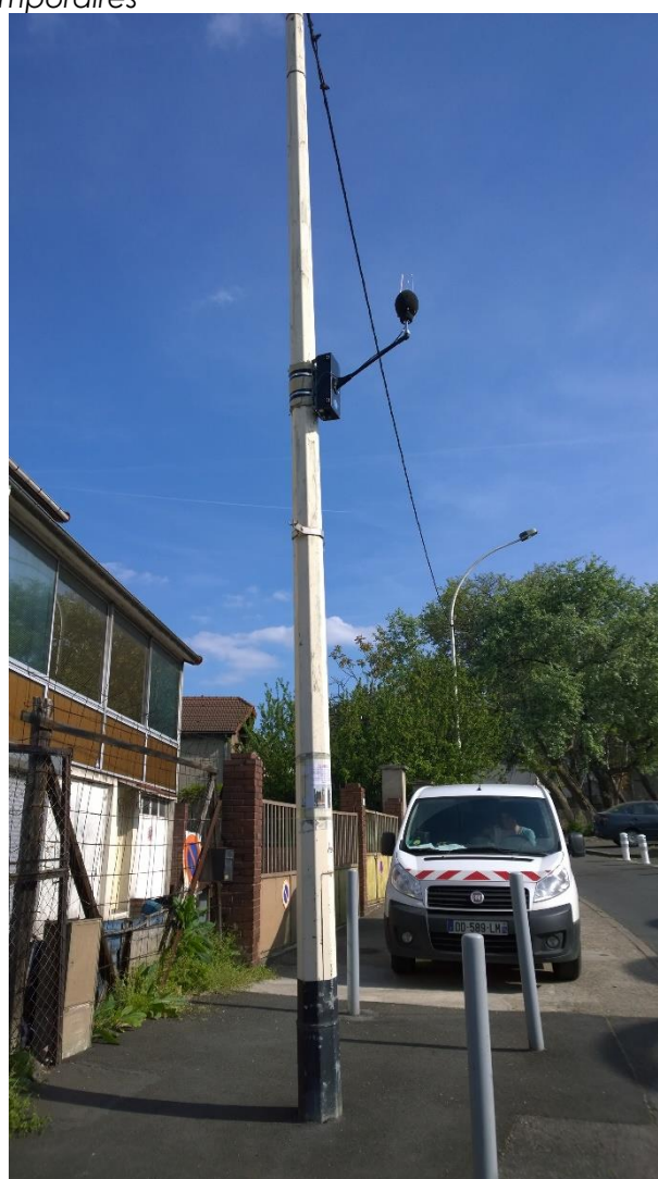
Mesure sur poteau d'éclairage
