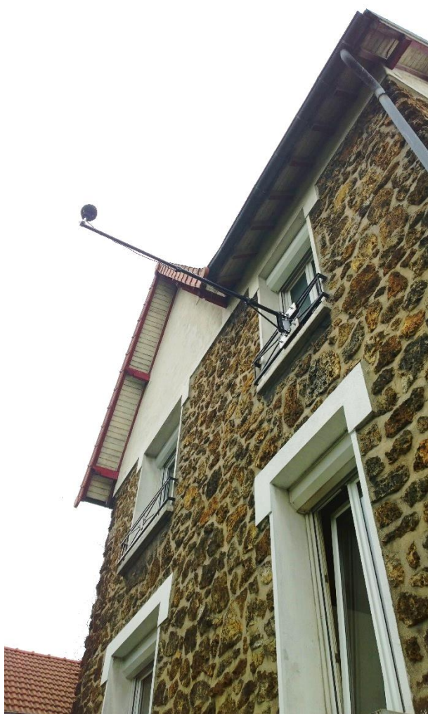
Mesure en façade
